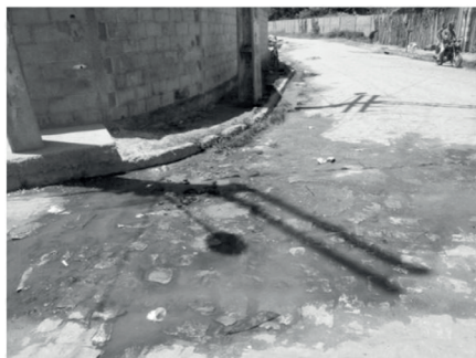
Figura 2 – Escoamento de material da Estação Elevatória de Esgoto para o rio da Estiva. Marechal Deodoro/ Alagoas, 2015
