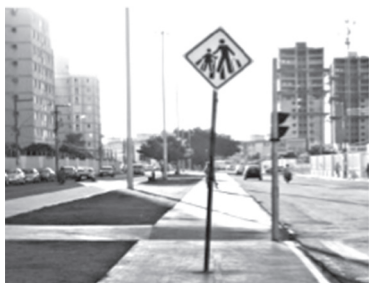
Figura 3 – Placa de sinalização no meio da ciclovia na Av. Canal 5 do Augusto Franco
