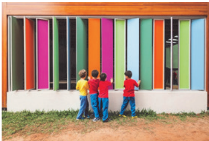
Figura 5 – Fachada interativa com a utilização de brises coloridos
