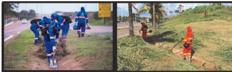
Figuras 7 e 8 – Ilustração de manutenção e conserva de dispositivos de drenagem.
