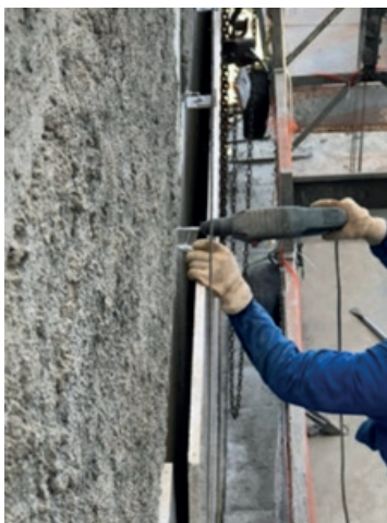
Figura 5 Perfuração sendo realizada sobre a base para suporte
