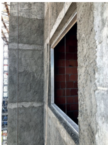
Figura 2 - Parte da fachada após aplicação de chapisco e demais tratamentos.
