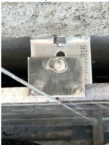
Figura 4 – Junta alinhada ao arame do prumo de fachada
