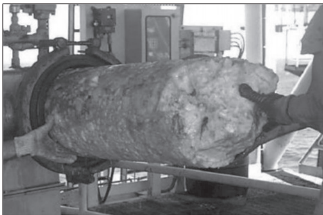
Figura 7 – Hidrato sendo removido de dentro de uma tubulação
