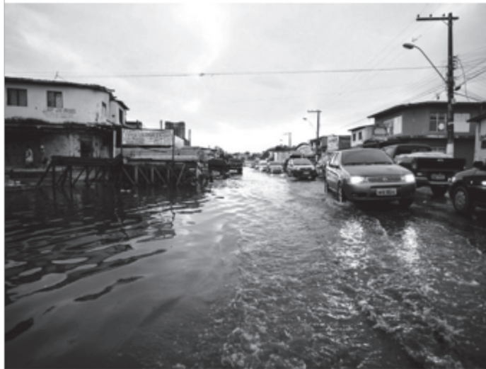
Figura 6 - Avenida ficou alagada após o nível da lagoa e de canal subir.
