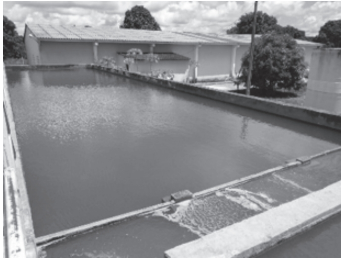
Figura 2 – Floco decantador
