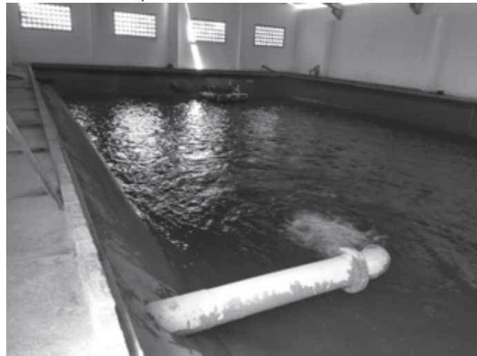
Figura 5 – Reservatório com capacidade de 1.700.000L
