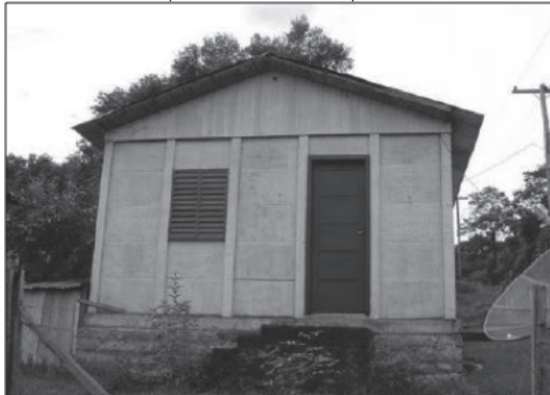
Figura 3 – Casa com estrutura pré-fabricada com placas cimentícias
