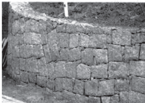
Figura 3 – Muro de arrimo do tipo gravidade
