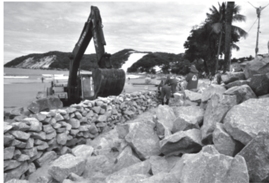
Figura 7 – Construção de enrocamento
