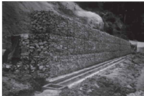
Figura 1 – Muro de gabião
