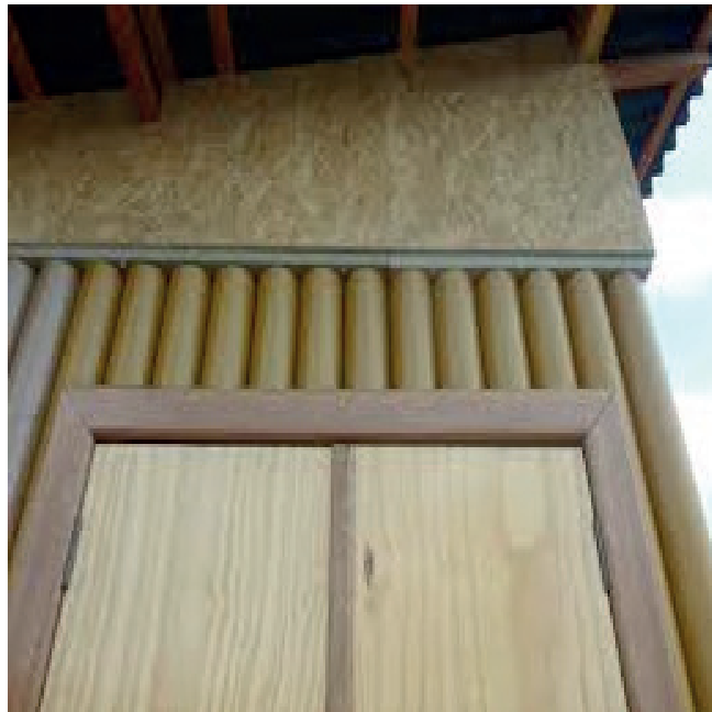
Figura 3 – Detalhe da ligação superior de vedação
