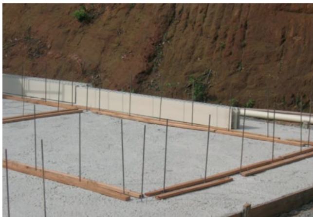
Figura 2 – Fixação de Ancoragens
