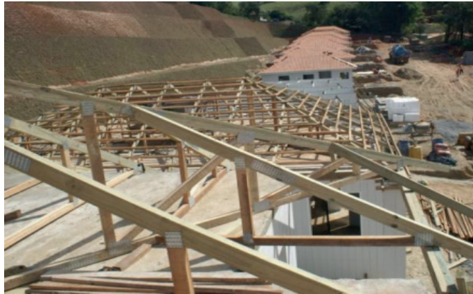
Figura 8 – Instalação cobertura e piso
