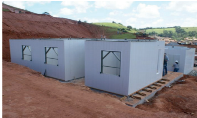
Figura 5 – Escoramento e Alinhamento
