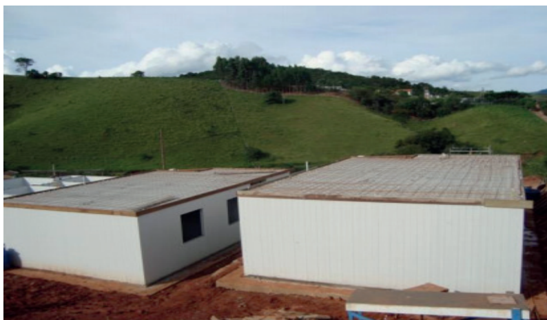
Figura 7 – Montagem laje
