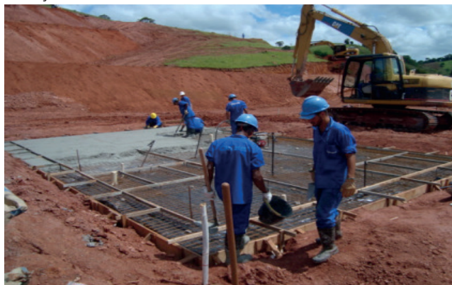
Figura 1 – Execução do Radier
