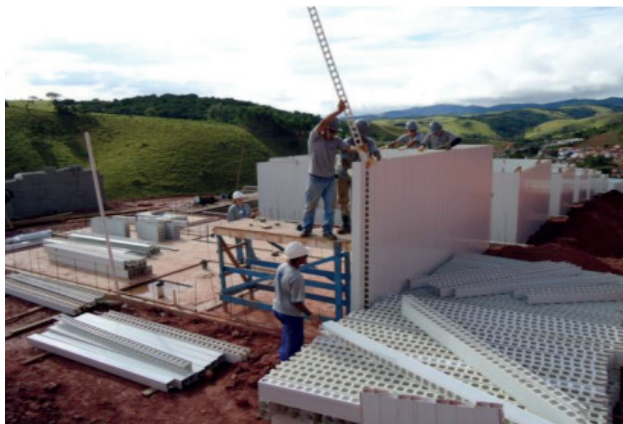
Figura 3 – Montagem das paredes
