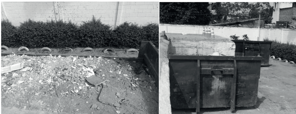
Figura 5 e 6 – Resíduos de gesso e contêiner-ECOPONTO
