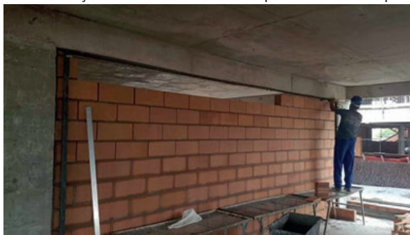
Figura 01 - Serviço de elevação de alvenaria de pavimento-tipo.
