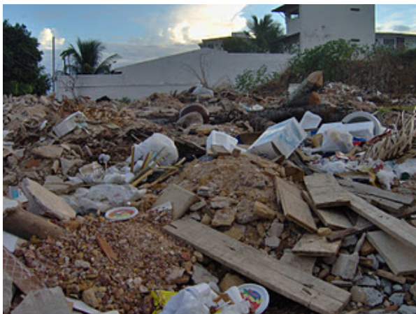
Figura 2 – Entulho da obra, grande quantidade de materiais descartados de forma irregular
