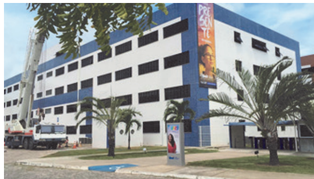
Figura 3 – Fachadas do Bloco D
