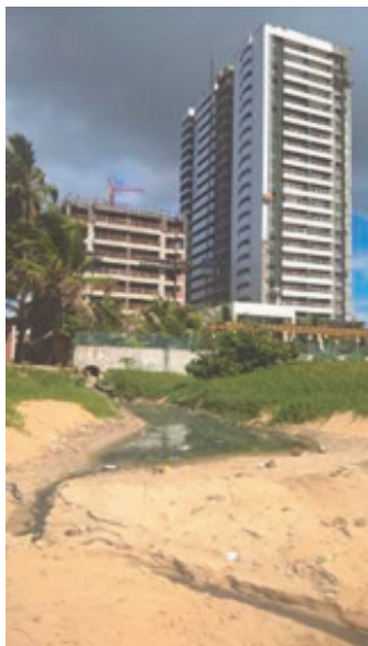
Figura 4 – Edifício Gran Marine em construção com “língua suja” aparente
