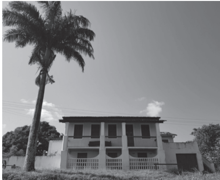
Figura 4 – Registro da Casa-grande do Engenho Grajaú de Cima, Pilar, AL
