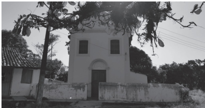
Figura 5 – Registro da Capela do Engenho Grajaú de Cima, Pilar, AL
