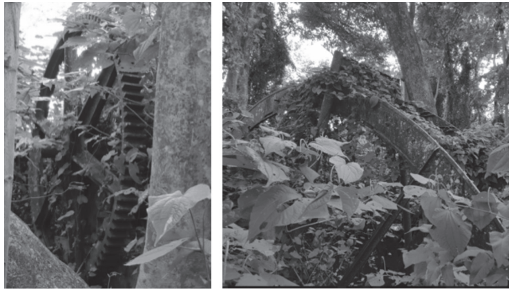
Figura 9 – Registro da roda d'água do engenho Grajaú de Baixo, Pilar, AL
