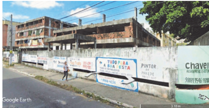
Figura 1 – Terreno de intervenção
