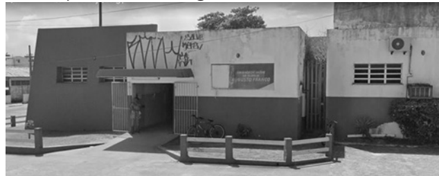
Figura 4 – Fachada Principal da UBS Augusto Franco
