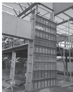
Imagem 7 – Utilização na obra
