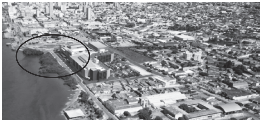
Figura 1 – Prédio do Aracaju Parque Shopping se destaca em meio as edificações preexistentes à sua implantação, iniciada em janeiro/2015
