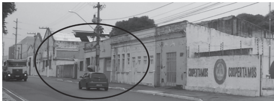
Figura 2 – Parte remanescente do conjunto que formava a vila operária pertencente a extinta Empresa de Tração Elétrica de Aracaju-ETEA. A tipologia das edificações é marcada pela horizontalidade
