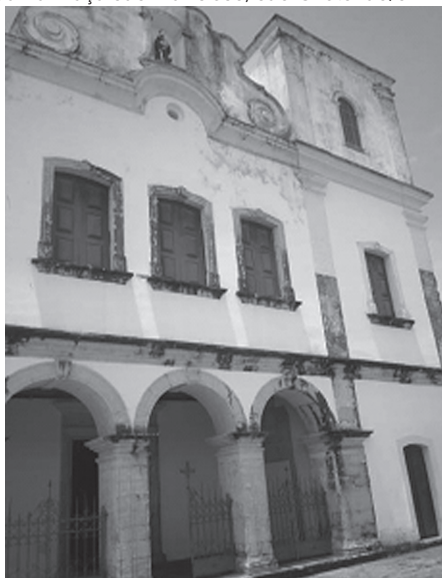
Figura 1- Igreja São Francisco, localizada na Praça São Francisco, São Cristóvão/SE.
