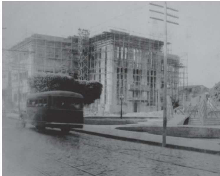
Figura 13 – Fotografia da remodelação do Palácio Serigy, concluída em 1938
