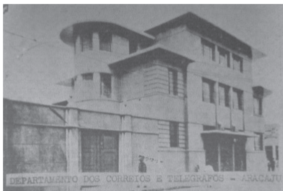
Figura 9 – Sede do Departamento de Correios e Telégrafos em Aracaju
