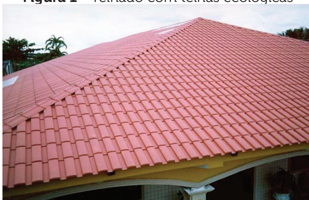
Figura 1 - Telhado com telhas ecológicas
