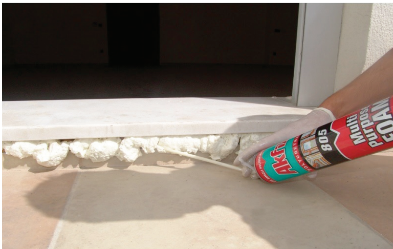
Figura 3 – Aplicação da espuma expansiva na fixação de esquadrias
