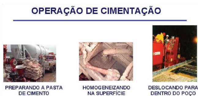
Figura 4 – Operação de Cimentação
