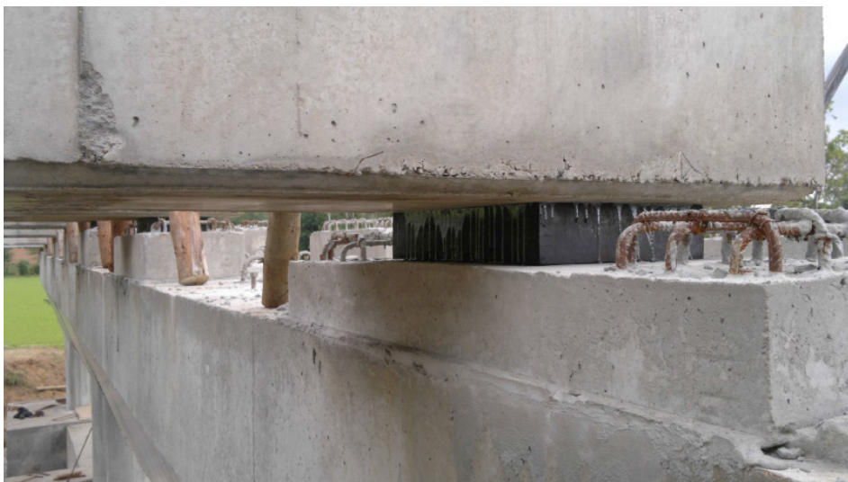
Figura 12 – Aparelho de apoio de neoprene oco, circular e retangular
