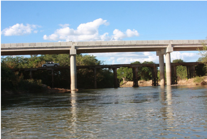
Figura 13 – Ponte sobre o Rio Peixotinho I (MT)
