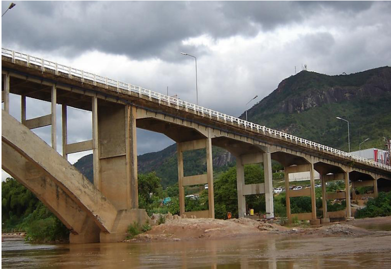
Figura 10 – Transversinas em uma ponte
