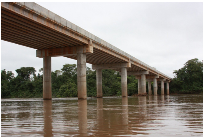
Figura 14 – Ponte sobre o Rio Cuiabá (MT)
