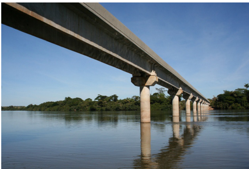
Figura 15 – Ponte sobre o Rio Teles Pires (MT)
