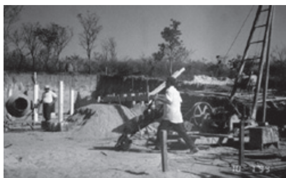
Figura 10: Execução da estaca Strauss
