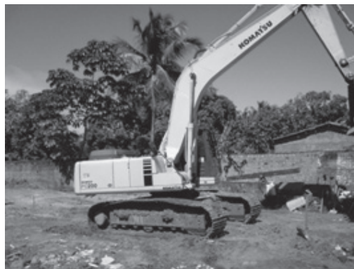
Figura 13: Escavação da obra do esgoto sanitário do bairro Santa Maria – Aracaju/SE
