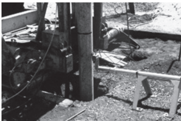
Figura 9: Cravação de estaca pré-moldada
