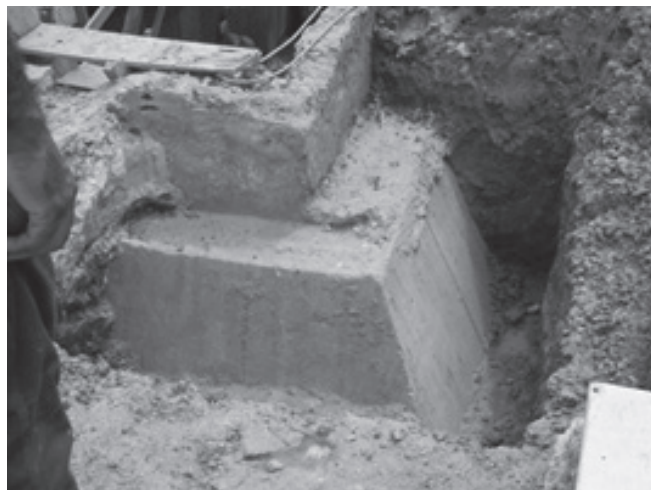
Figura 7: Estacas do Hospital de Urgência Sergipe. Aracaju/SE
