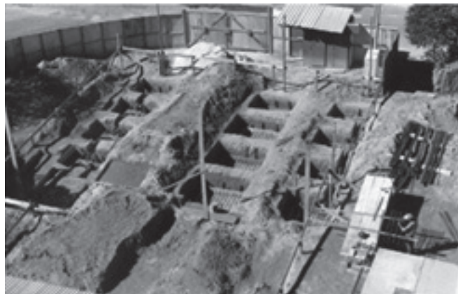
Figura 4: Obra de fundação por sapatas
